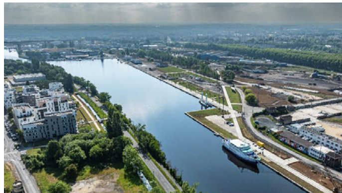
Site pilote : redirection du Nouveau Bassin
